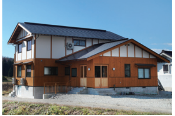
仕様書に沿ってつくられた「金山杉住宅」 (設計：阿部建築研究室、施工：小野工務店)
